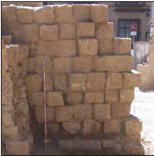
Fig. 3 - Muralla musulmana, cara interior. A la izquierda se observa cajón romano.
